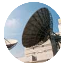
Sostituzione linea dedicata
